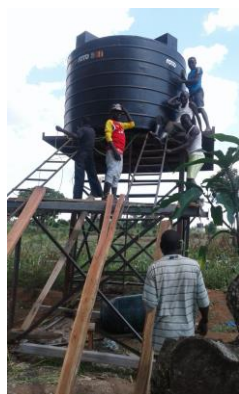
Montaggio di un tank di stoccaggio per l'acqua da potabilizzare
