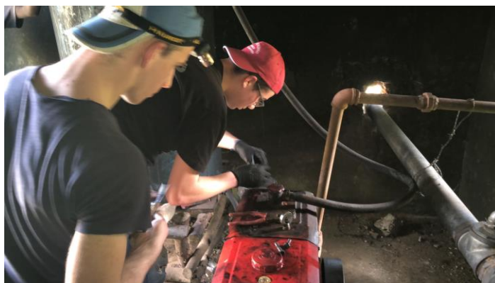
I ragazzi dell'ist. Sartor riparano la pompa per l'irrigazione
